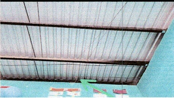
FOTO 7: REPARACIÓN DE SISTEMA ELÉCTRICO
