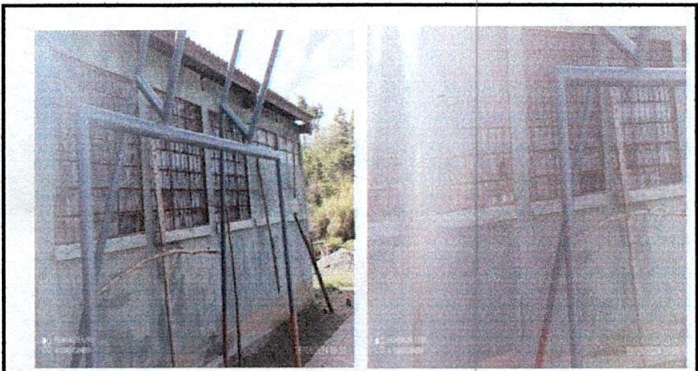
FOTO 15: REPARACIÓN DE MURO PERIMETRAL DE BLOCK CON TUBO HG Y MALLA GALVANIZADA, SOLERAS INTERMEDIAS Y COLUMNAS
